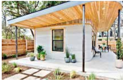
ICON 首次获准使用 3D 打印房屋 奥斯汀（德克萨斯州）2018 年 3 月 照片来源：Regan Morton 摄影
