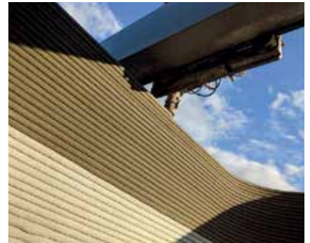
ICON Vulcan 建筑系统 3D 打印住宅
